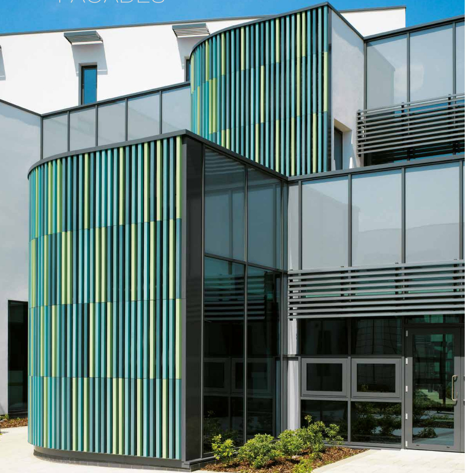
Finchley Memorial Hospital, London, Großbritannien · United Kingdom Architekt · Architect: Murphey Philipps Architects, Großbritannien · United Kingdom / Photo: Benedict Luxmoore
