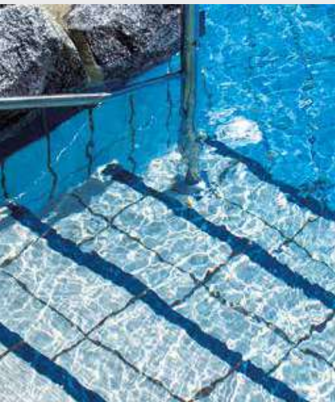
Ins Wasser führende Treppe mit Rillenplatten Stairs leading into the water with grooved tiles
