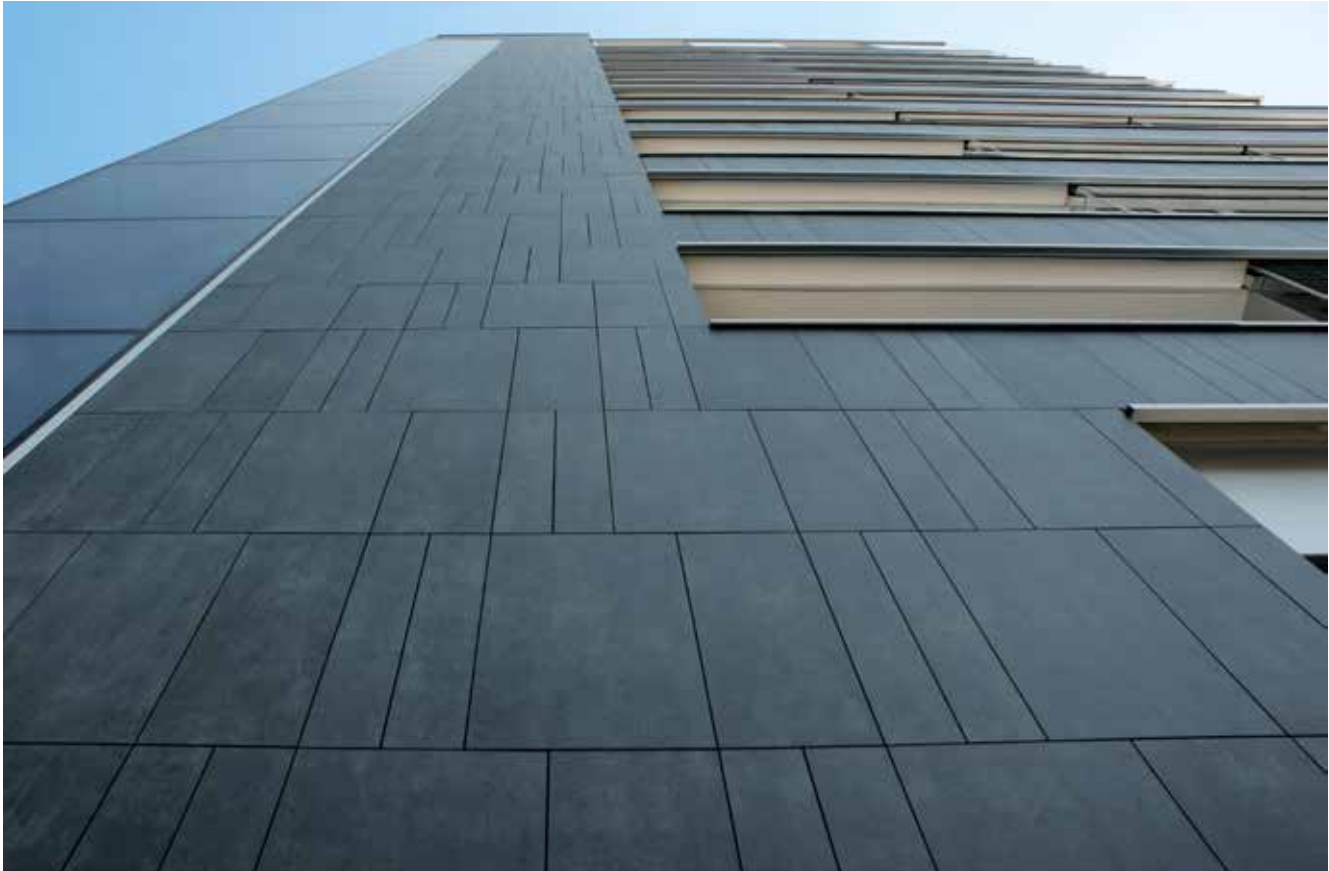
Einkaufszentrum Migros Baar, Schweiz · Switzerland / Architekt · Architect: Theo Hotz AG Architekten + Planer / Photo: Adriano Faragulo
